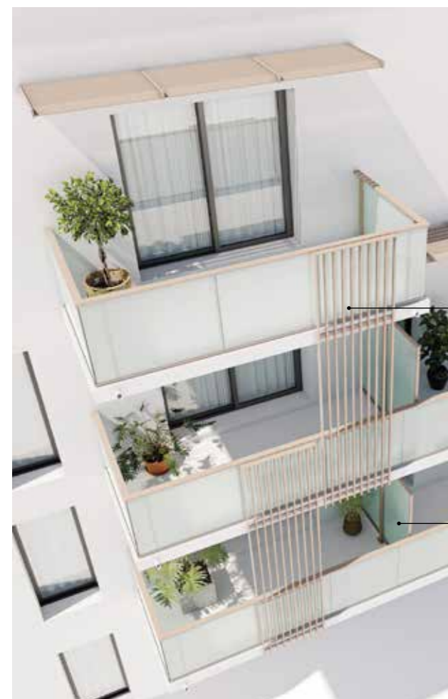
Casquette, garde-corps vitré, séparatif de balcon et claustra décoratif à lames verticales.
